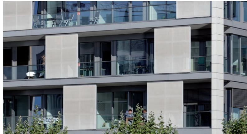
Das System FACID M eignet sich zur Realisierung von modularen und vorgefertigten Fassadenrahmen. Das modulare Rahmensystem, mit dem das äussere Erscheinungsbild eines Gebäudes ohne funktionelle Einschränkungen schnell und effizient an veränderte Anforderungen angepasst werden kann. Die filigran und leicht wirkenden Elemente bieten mit ihren flächenstabilen Gewebeflächen eine perfekte rahmenfreie Frontoptik.
