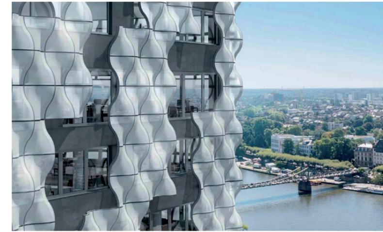
Die innovative Weiterentwicklung des Textilfassadensystems FACID 65 eröffnet neue Gestaltungsspielräume für moderne textile Fassaden, die mit organischen sowie geschwungenen Fassadenformen hervorstechen. Ausserdem ermöglicht das wegweisende System für unterschiedlichste Gebäudetypen architektonisch anspruchsvolle Fassadenlösungen.
