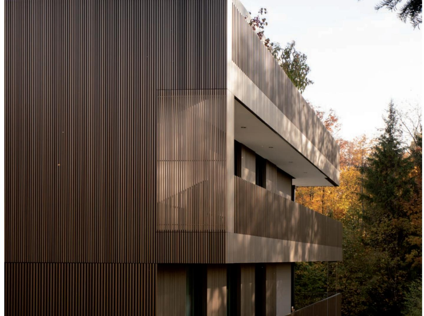
Die Lamellen sind in drei unterschiedlichen Profilformaten in 45 oder 102 mm Breite erhältlich. Sie lassen sich farblich variabel gestalten und sehr gut in architektonische Farbkonzepte integrieren. Zudem sind auch objektbezogene, individuelle Lamellen-Querschnitte möglich.
